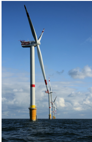
a) Éoliennes à axe horizontal
